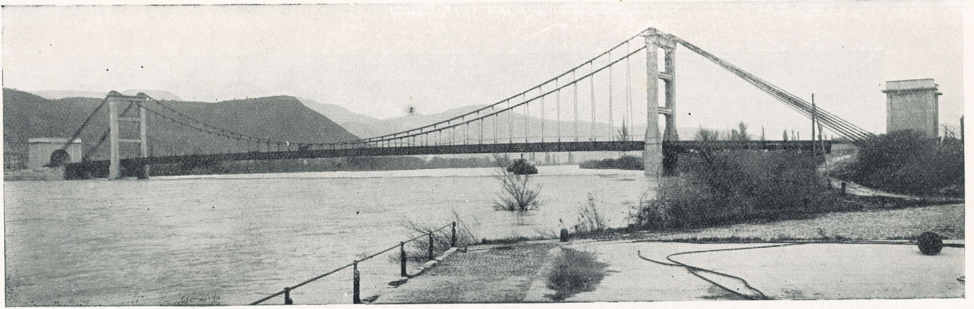
LE NOUVEAU PONT DU TEUIL
