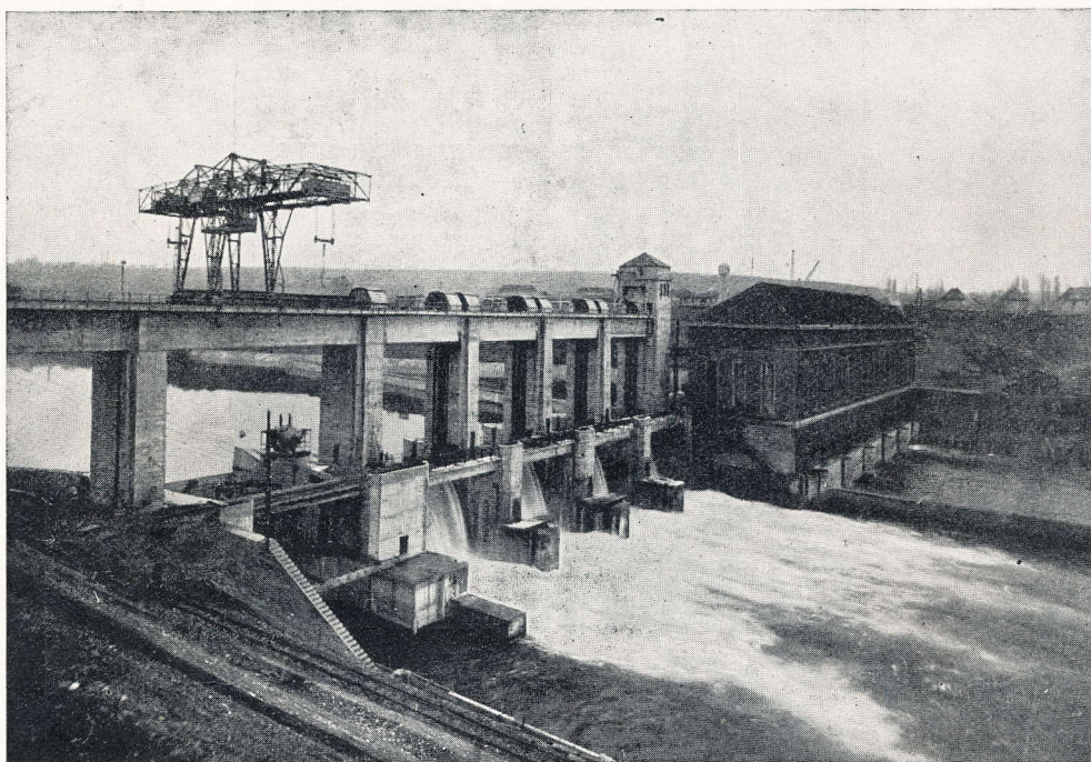
Barrage et usine de Chancy-Pougny
