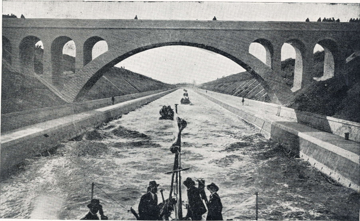
Tranchée de Gignac (Canal de Marseille au Rhône)
